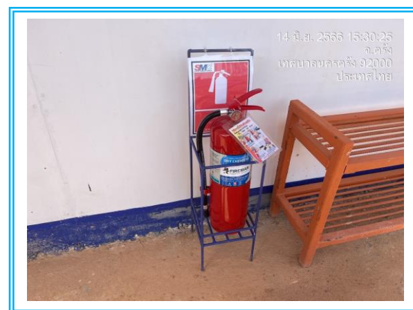
รูปที่ 3.1-45 ถังดับเพลิงเคมีชนิดมือถือ ภายนอกพื้นที่โครงการ
