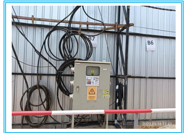
รูปที่ 3.1-36 อุปกรณ์ตัดกระแสไฟฟ้า
