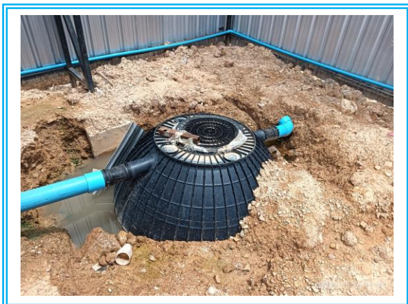
รูปที่ 3.1-27 ถังบำบัดน้ำเสียสำเร็จรูปในพื้นที่โครงการ
