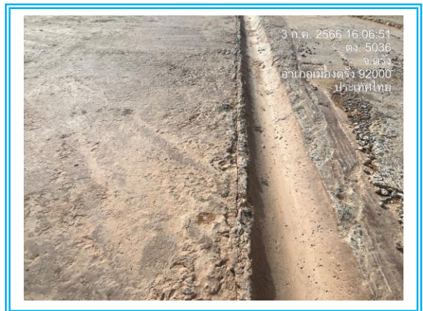
รูปที่ 3.1-44 รางระบายน้ำรอบพื้นที่ก่อสร้างโครงการ
