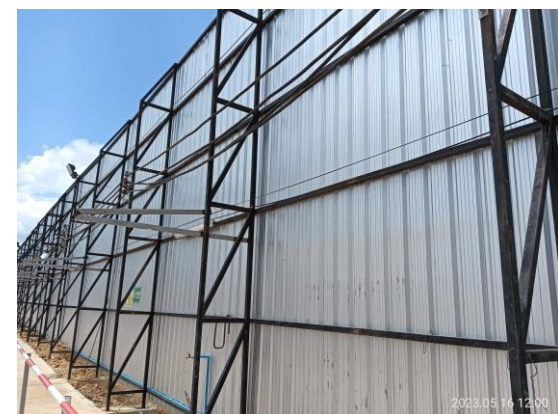
รูปที่ 3.1-2 รั้ว Metal Sheet สูง 6 เมตร
