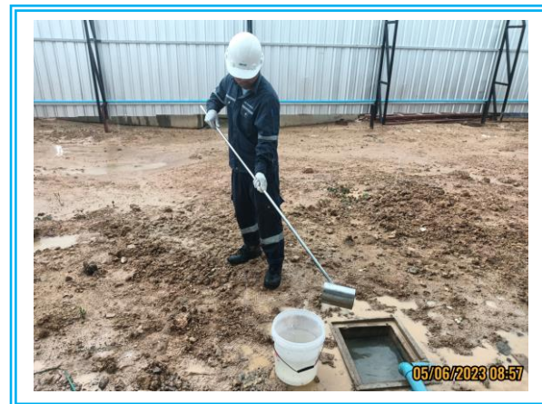
รูปที่ 3.1-43 ปอดักตะกอนภายในพื้นที่ก่อสร้าง
