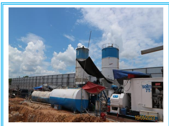
รูปที่ 3.1-17 ถังไซโลสำหรับเก็บปูนซีเมนต์
