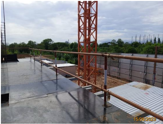
รูปที่ 3.1-67 ราวกันตกหรือตาข่ายนิรภัย สำหรับการ ทำงานบนที่สูงเกิน 4 เมตรขึ้นไป
