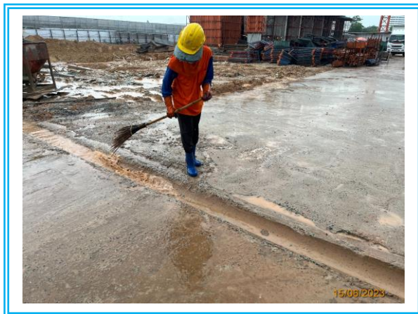
รูปที่ 3.1-21 การขุดลอกตะกอนที่สะสมในรางระบายน้ำ
