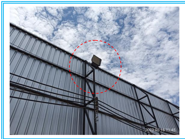
รูปที่ 3.1-59 ไฟฟ้าส่องสว่างตลอดแนวรั้วก่อสร้างโครงการ
