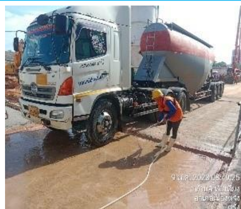
รูปที่ 3.1-12 จุดล้างล้อรถบรรทุกก่อนออกนอกพื้นที่โครงการ
